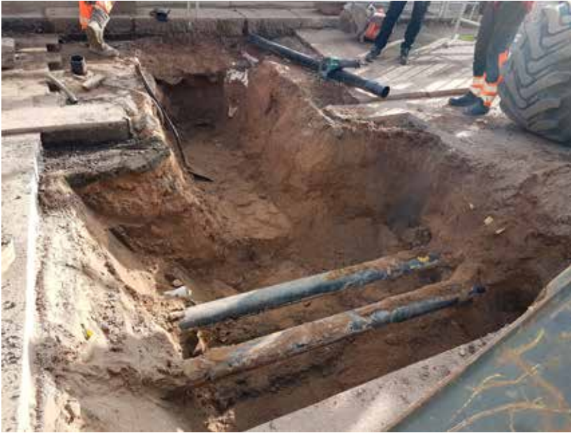
Figur 3. Schaktet med två fjärrvärmerör och rester av det borttagna dräneringsröret i bakgrunden. Foto mot öster. (Fotonr. 2024-20-1). Foto: Patrik Hallberg.
